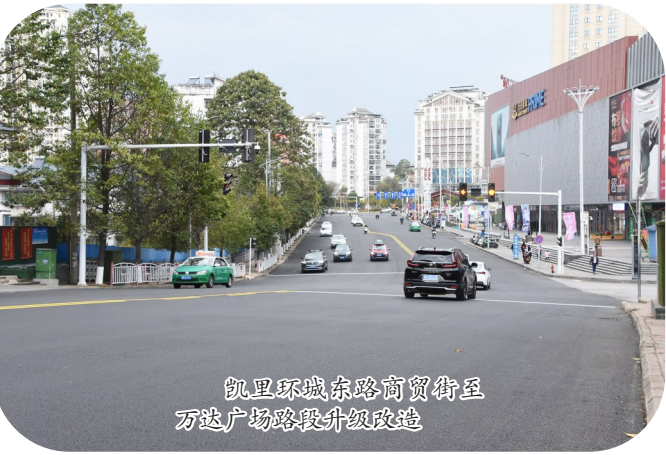
凯里环城东路商业街区 万福广场建设加快推进
