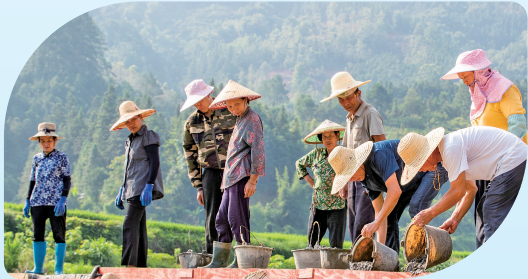
从江县刚边壮族乡三联村村民在进行饮用水供水管道修缮作业 (从江县水务局提供)
