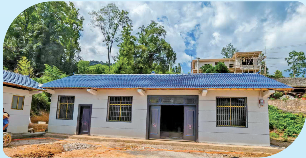
经过危房改造后的房屋 (图片由黔东南州住房和城乡建设局提供)
