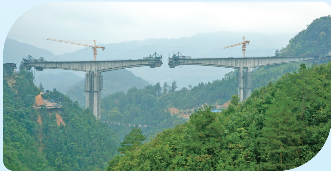
建设中的信洞大桥 (通讯员 胡宪林 摄)
