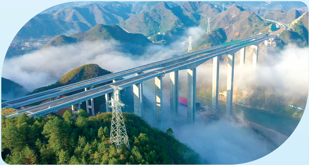
凯里北环高速清水江大桥 (通讯员 敬南钦 摄)
