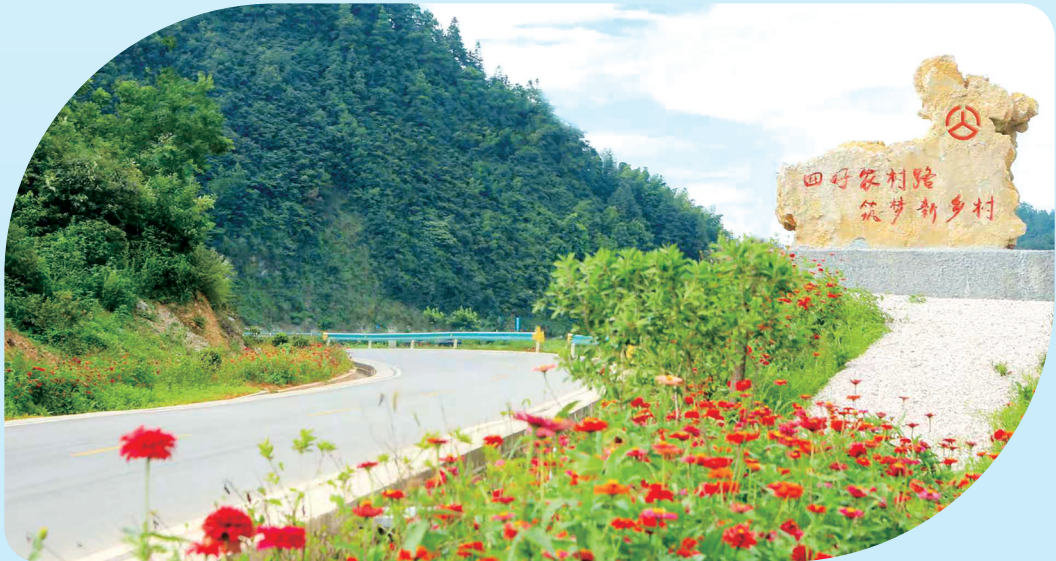
黎平中潮至洪州段公路 (通讯员 陈代忠 摄)
