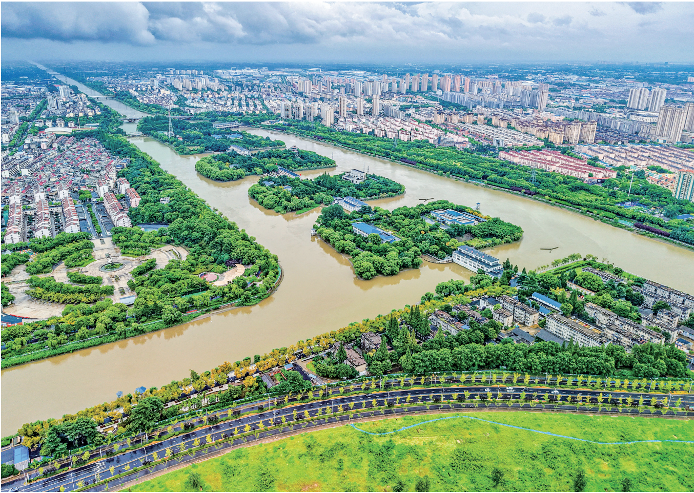
8月11日拍摄的位于江苏省扬州市江都区的南水北调东线源头江都水利枢纽。(新华社发 任飞 摄)
